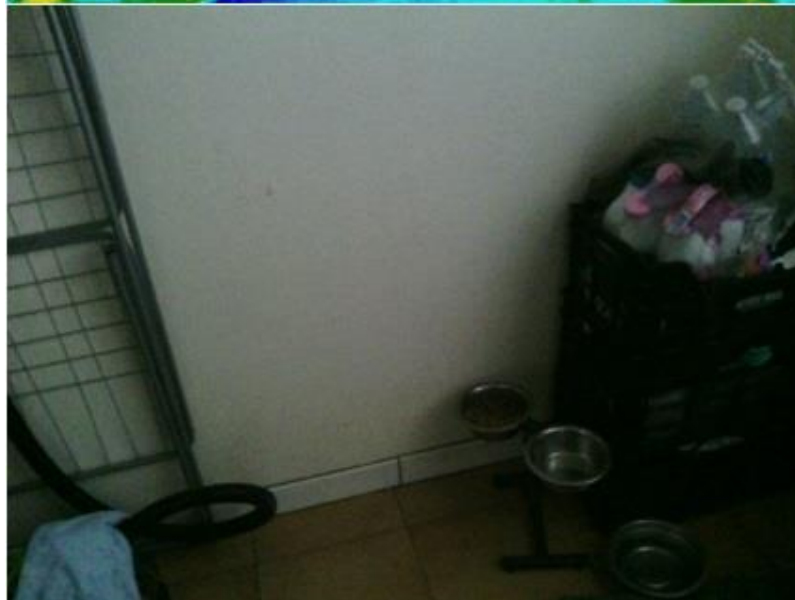
RELEVÉ CAMERA THERMIQUE_Pont thermique plancher bas/mur
